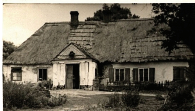
Po wojnie dwór był opuszczony i niszczał. Dworek i zabudowania folwarczne, m.in. drewniany spichlerz z 1. poł. XIX w., istniały do początku lat 70. XX w., kiedy to dwór został rozebrany
